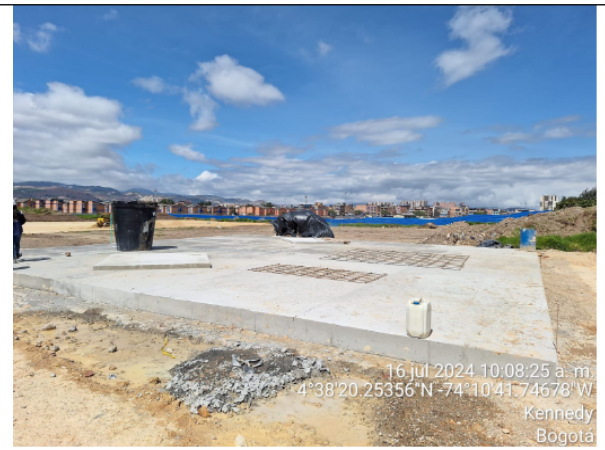
Fotografía No. 10: Placa para emplazamiento de maquina pilotaje en área de intervención.
