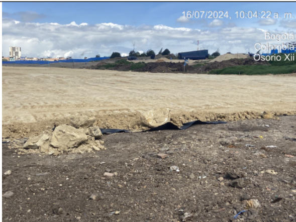
Fotografía No. 5: Espesor de capa de compactación y nivelación
