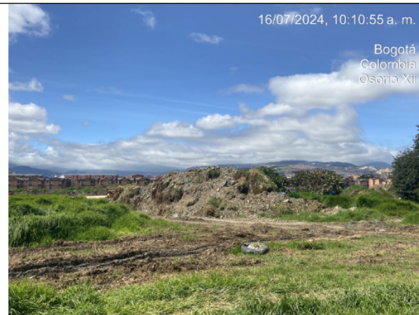
Fotografía No. 9: Área de acopio temporal de material extraído de relleno antrópico.
